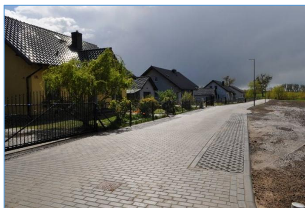
Droga po przebudowie
