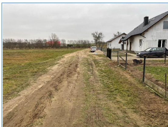
Stan drogi przed przebudową
